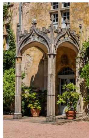
Portique néogothique du château
