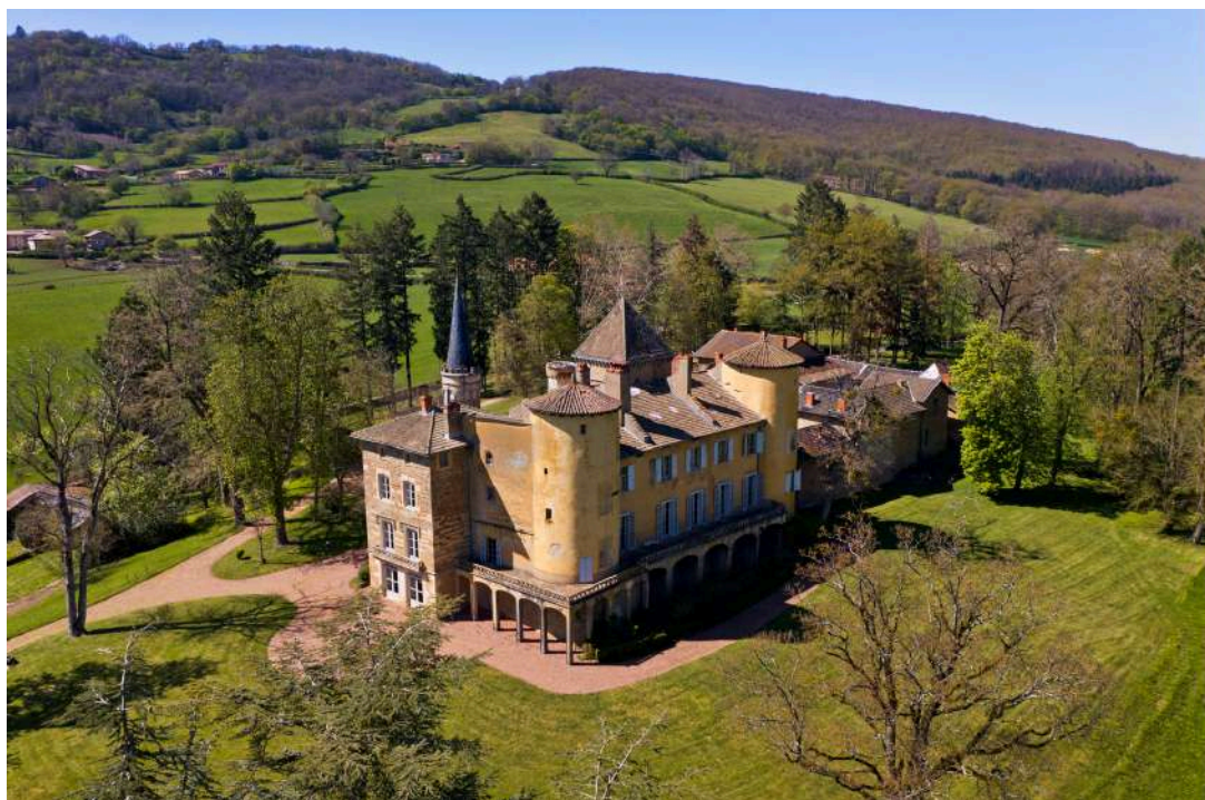
Façade sud-est du château de Saint-Point
