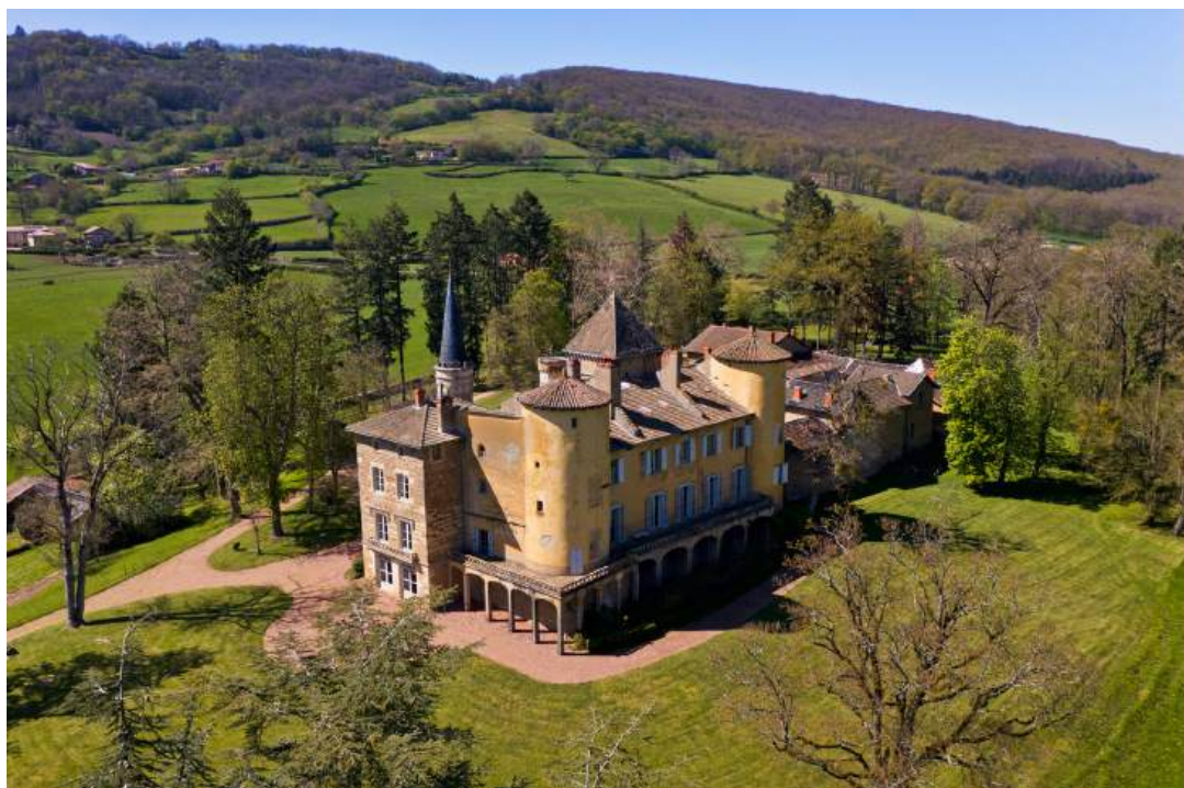
Façade sud-est du château de Saint-Point
